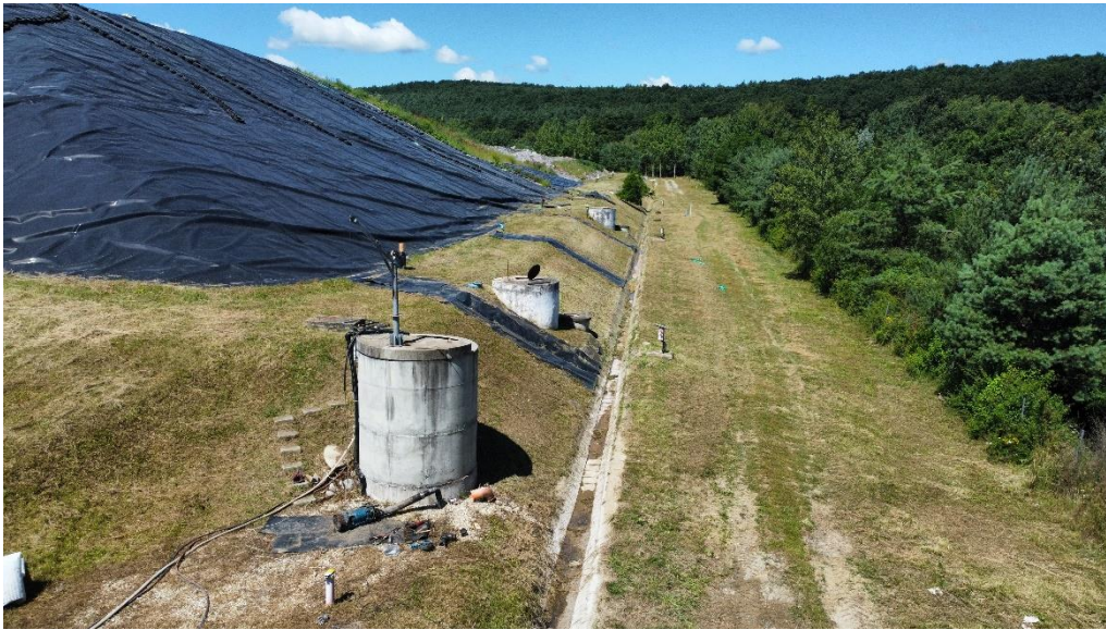
8. kép: A III. és IV. depóniák csurgalékvíz-gyűjtő és szivárgó aknáinak K-i irányból (2024. július)
