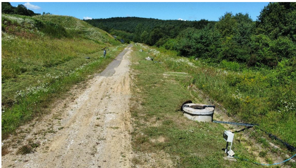
7. kép: Az I. és II. depóniák csurgalékvíz-gyűjtő aknái K-i irányból (2024. július)
