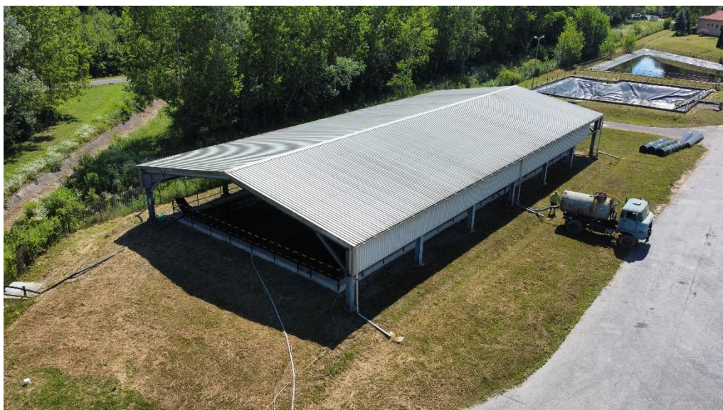
12. kép: Az átépített I. csurgalékvíz-gyűjtő medence ÉNy-i irányból (2024. július)
